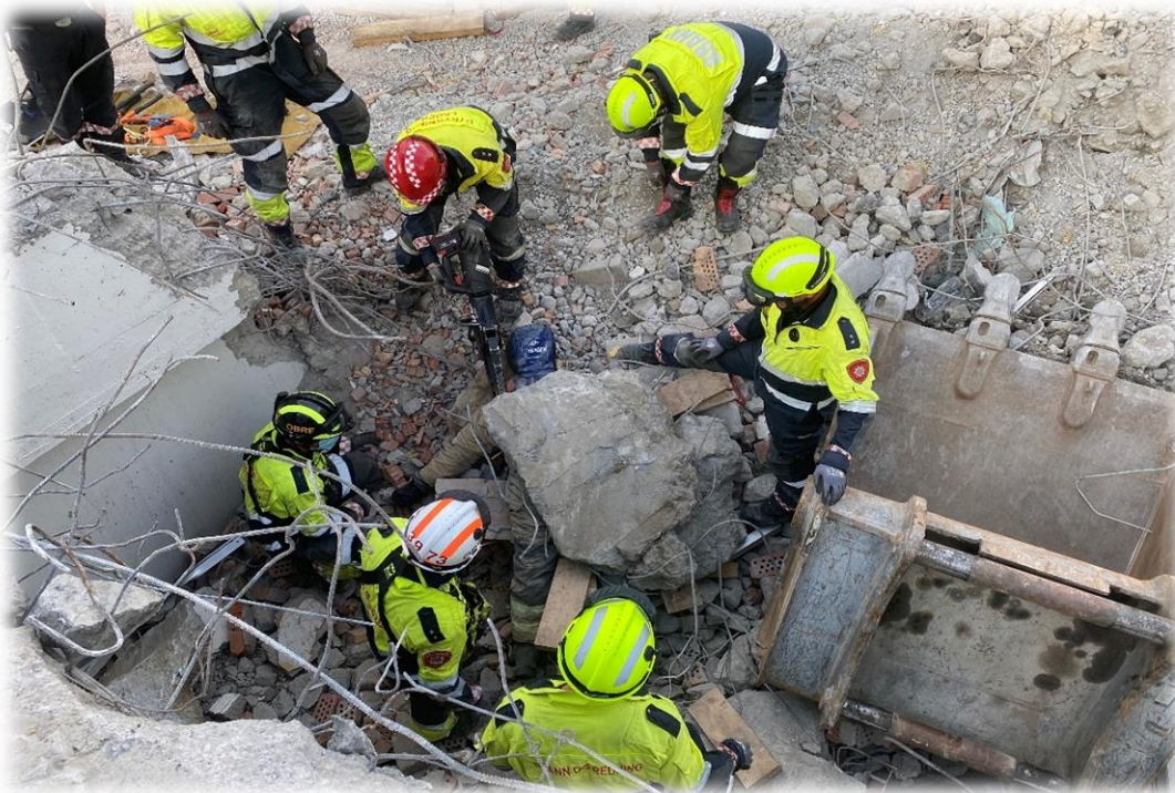
Figur 4 Øvelse sammenraste bygg, sammen med Oslo Brann og Redningsetat.
