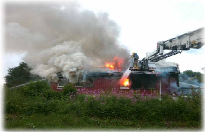
Brann i Ski sentrum i juli, ingen personskader, men huset ble totalt skadd.
